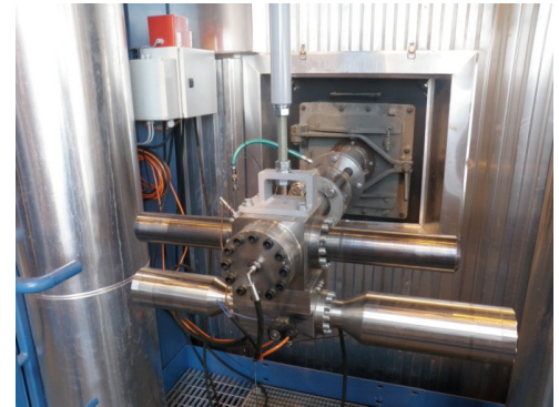
Explosionsgenerator EG10 montiert
