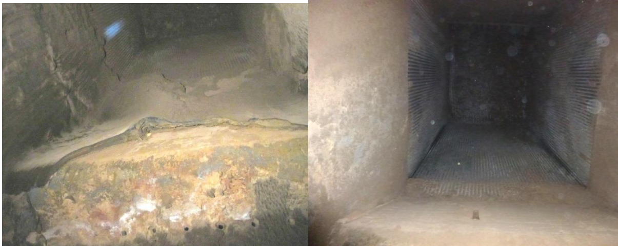
Abb. 8a: Zustand des Feuerraums nach 10 Wochen Reisezeit, im Jahr 2010, ohne Betrieb von Shock Pulse Generatoren.
