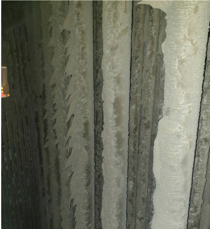
Abb 4: Unterschied in den Oberflächen bei Kesselbündeln:
