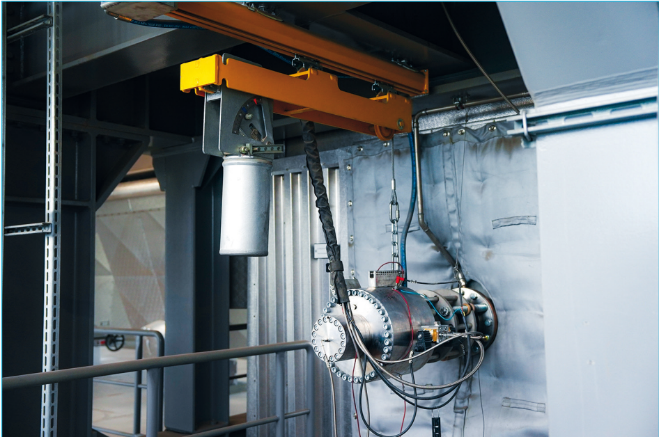
Abb. 2: Shock Pulse-Generator SPGr10 im eingebauten Zustand, hier: Einbau an einem Mannloch
