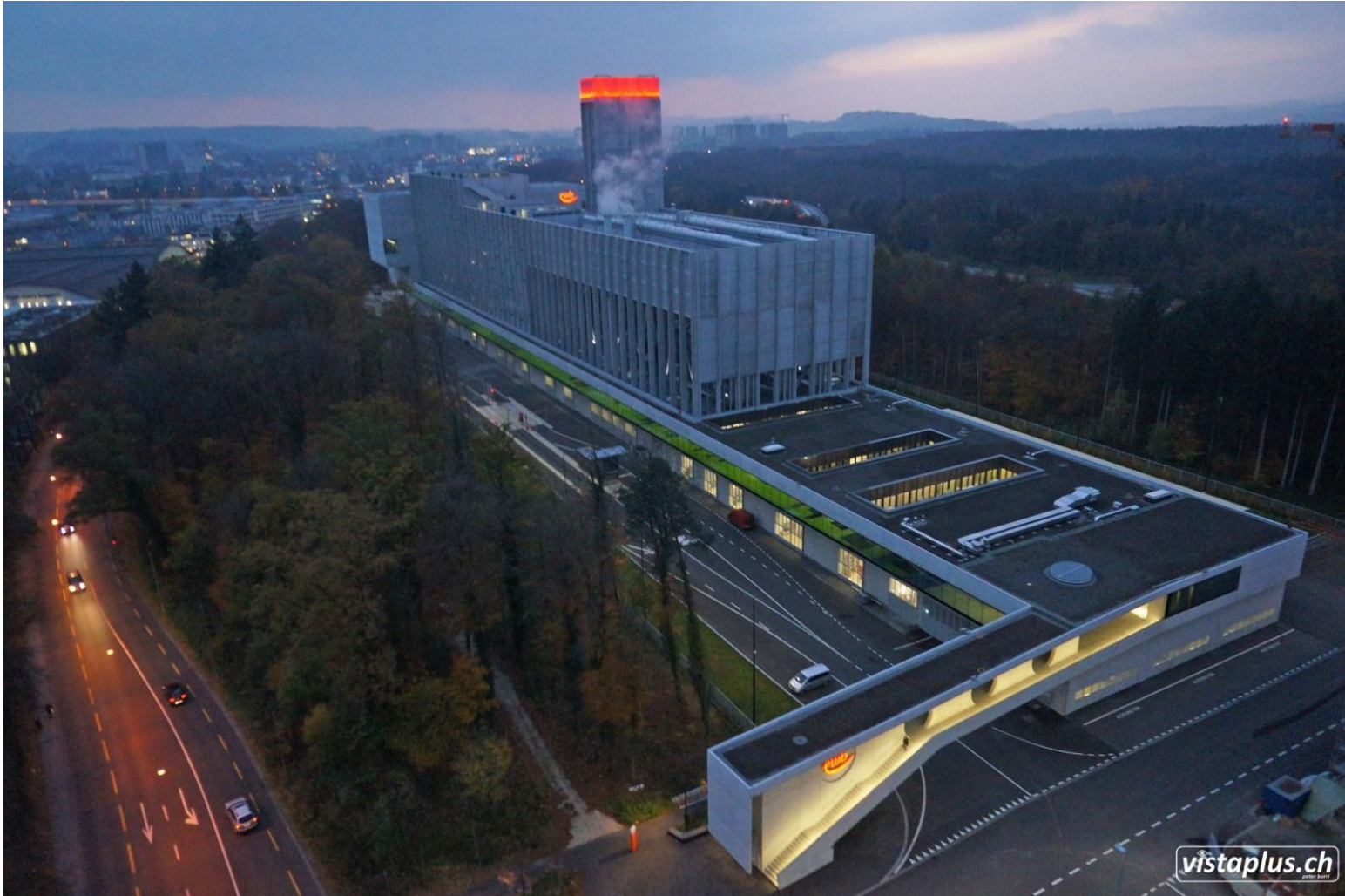
Energie Wasser Bern (ewb)
