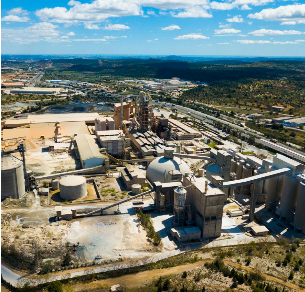
Drohnenaufnahme des Zementwerks (Industrieareal)
